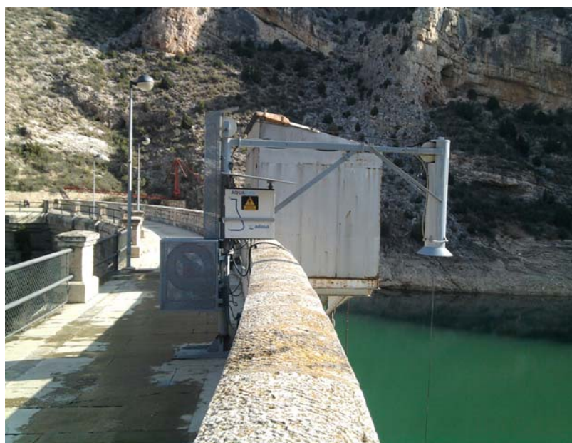
Sonda Aquadam instalada en el embalse de Cueva Foradada
