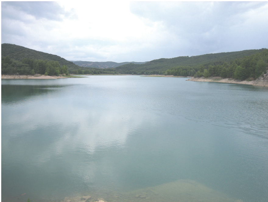
Foto 2: Panorámica del embalse desde la presa
