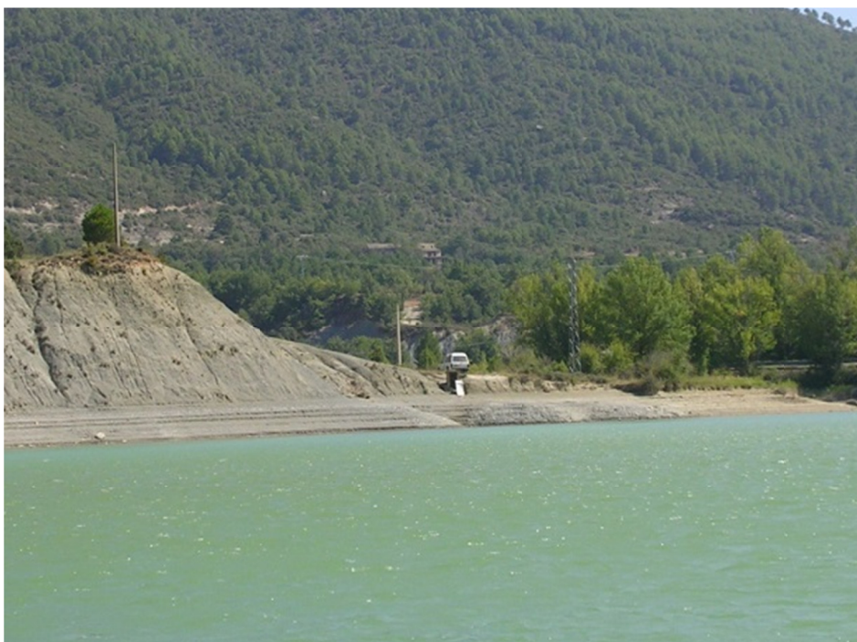
Figura 8. Vista del punto de acceso
