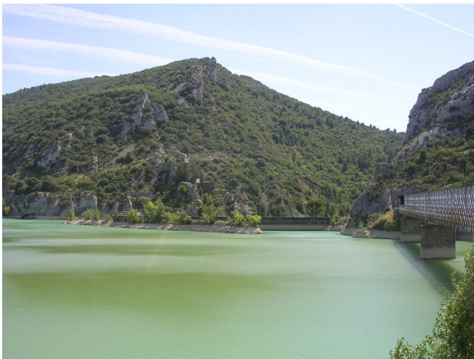
Figura 7. Vista de la presa del embalse
