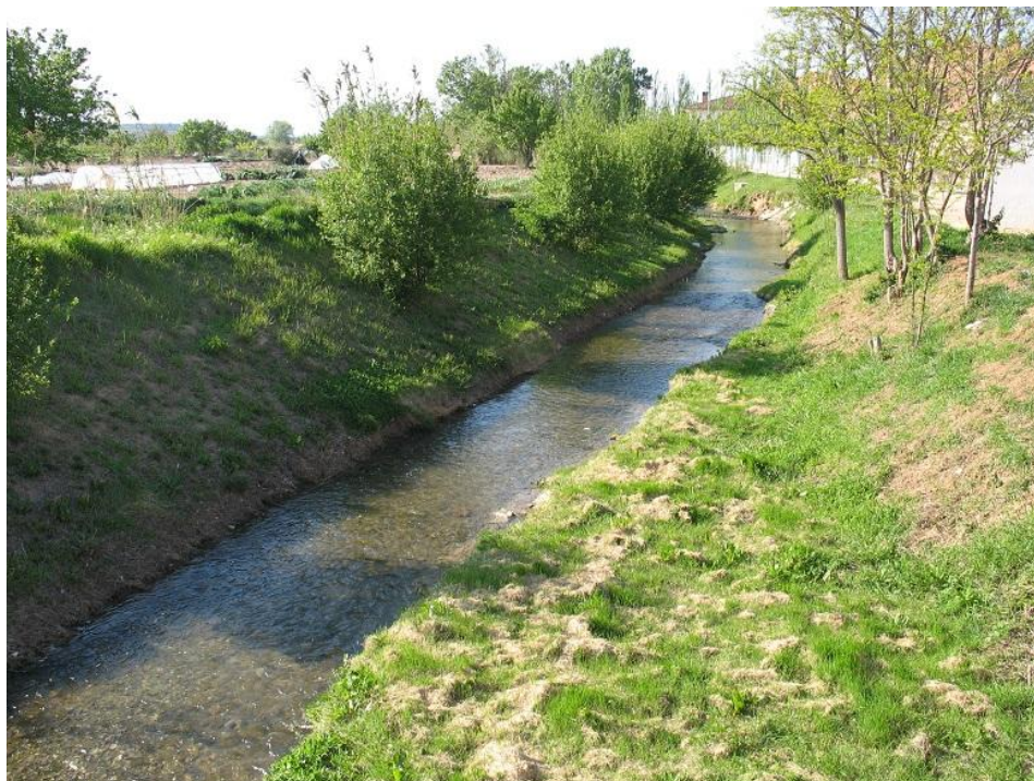
Figura 30-12. Cauce alterado y ribera prácticamente eliminada en la localidad de Tulebras.
