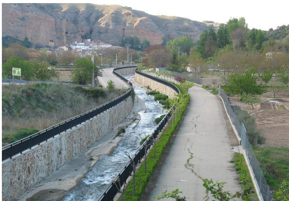
Figura 30-16. Cauce canalizado del río Val aguas abajo del embalse de El Val.
