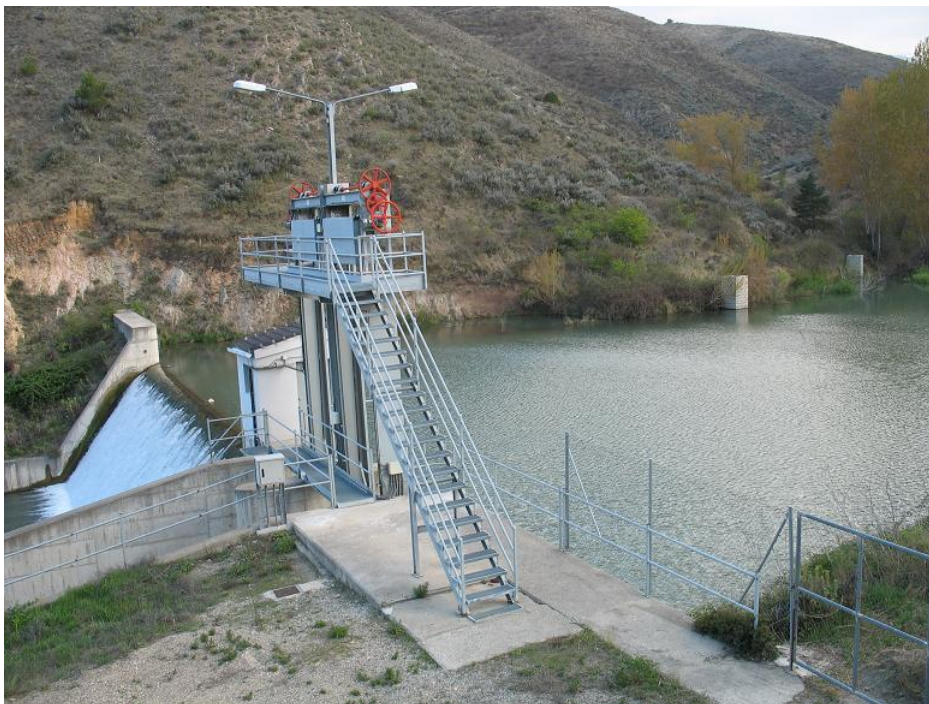
Figura 30-4. Azud de derivación en el río Queiles hacia el embalse de El Val.
