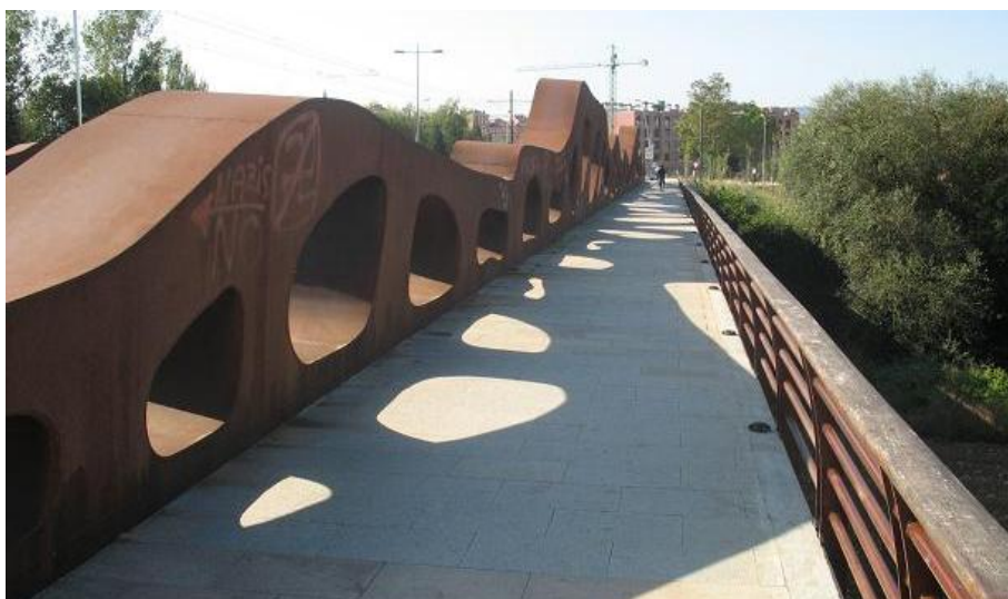
Figura 2-1. Puente sobre el río Zadorra en Vitoria.
