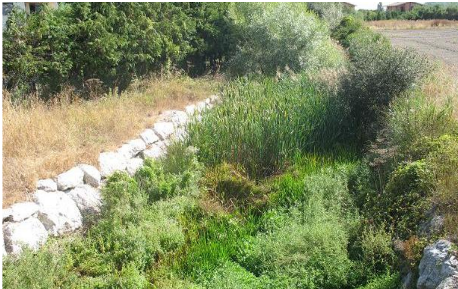
Figura 2-4. Defensas puntuales de margen cerca de Salvatierra.
