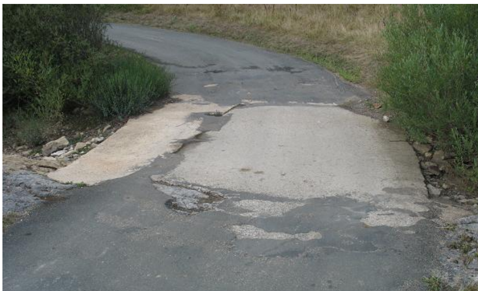
Figura 2-33. Vado sobre el cauce del río Zayas
