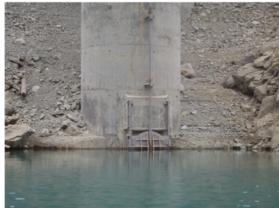
Vista de la torre de captación y del sustrato en la zona litoral de la presa.
