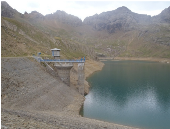
Vista de la torre de captación y de parte de la presa.
