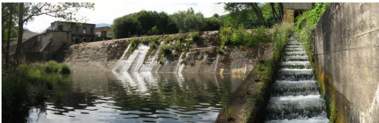
Fig. 3. Vista del azud y de la escala de peces desde la margen izquierda
