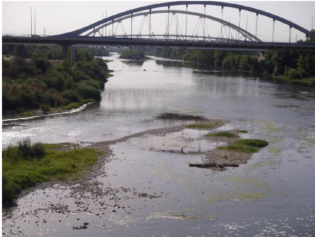
Foto 31: Tramo 1; Azud de Zaragoza, aguas abajo, zona central. 27 de julio de 2012.
