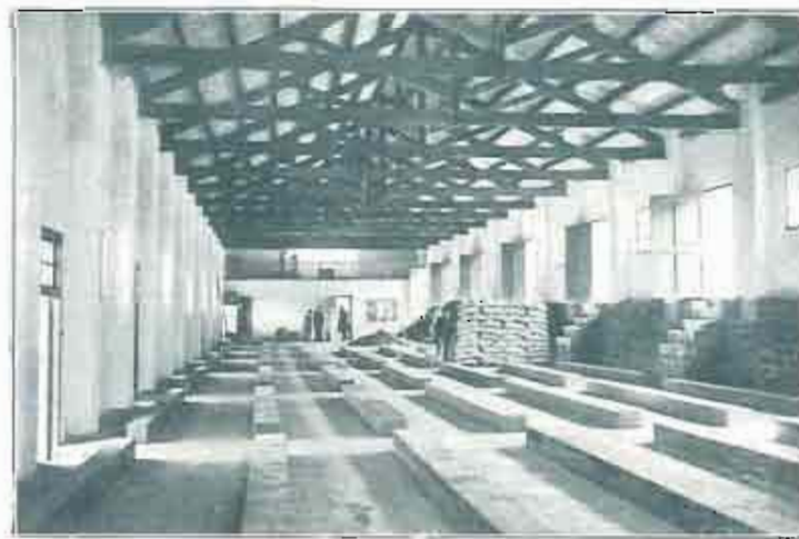
PANTANO DEL EBRO: Interior del almacén de cemento de la Confederación.
