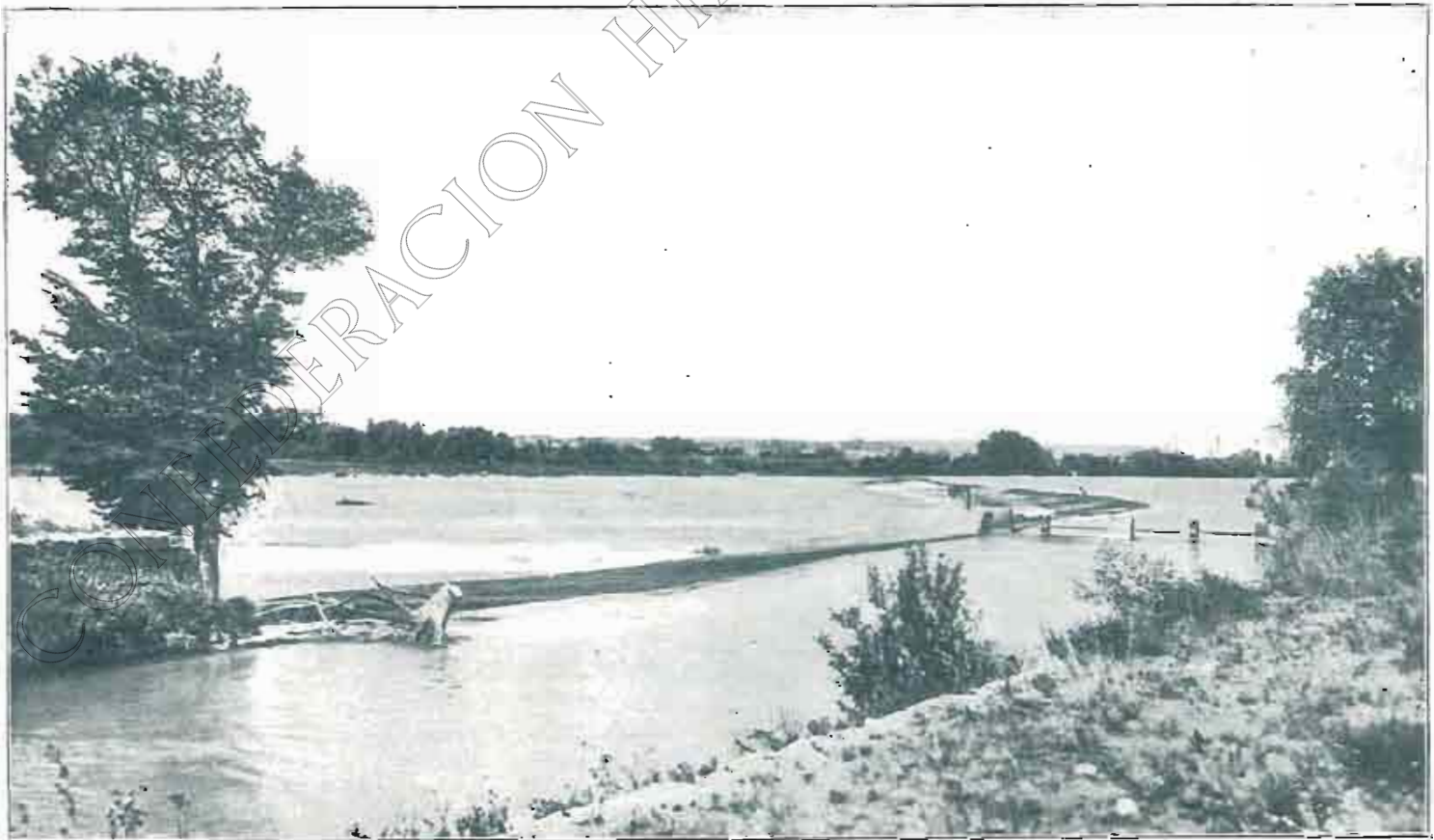
CANAL DE TAUSTE: Presa en el Ebro para la toma de aguas del canal.
