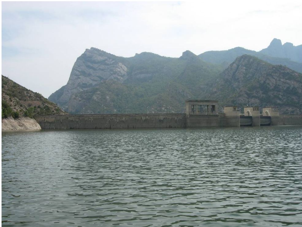
Vista de la presa desde la estación de muestreo (E1). Verano de 2005 (07/2005)
